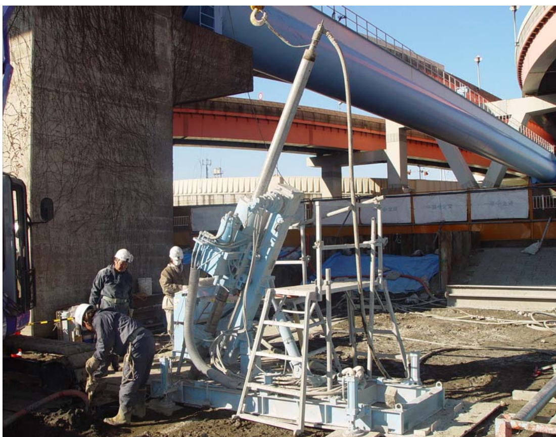
写真 1.1-1 CPR 工法の施工状況（東京都水道局綾瀬川水管橋耐震補強工事）
