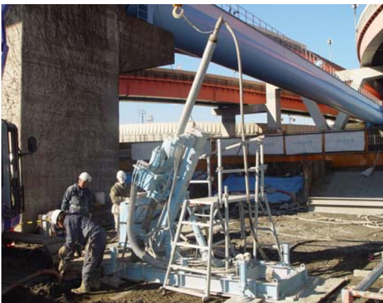
東京都水道局綾瀬川水管橋耐震補強工事
